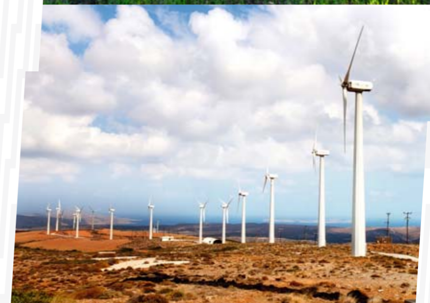
Πάνω: Αποκατάσταση εδάφους, Μεγαλόπολη Κάτω: Μονή Τοπλού, ανεμογεννήτριες
