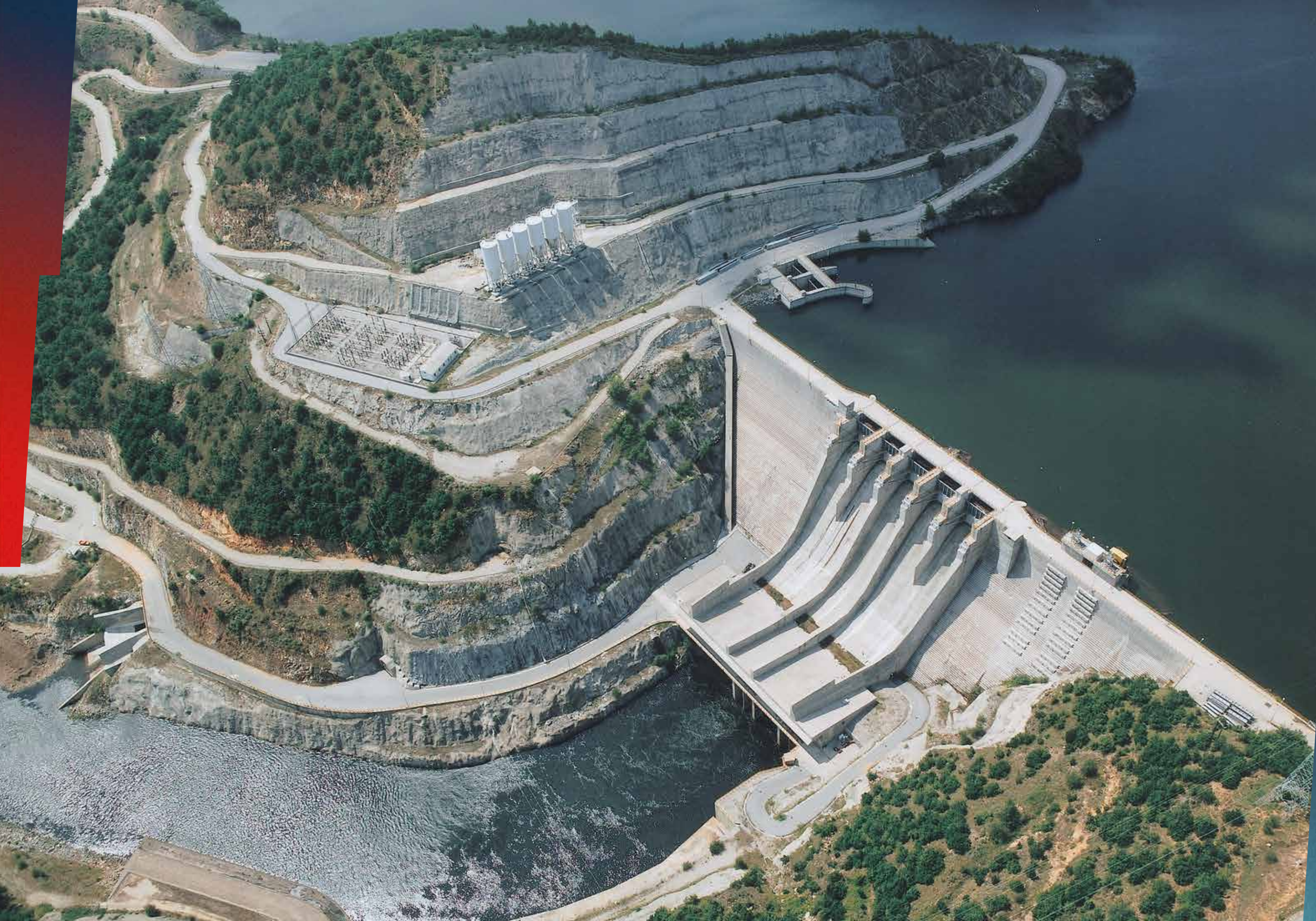
Υδροηλεκτρικός Σταθμός - φράγμα - Πλατανόβρυση
