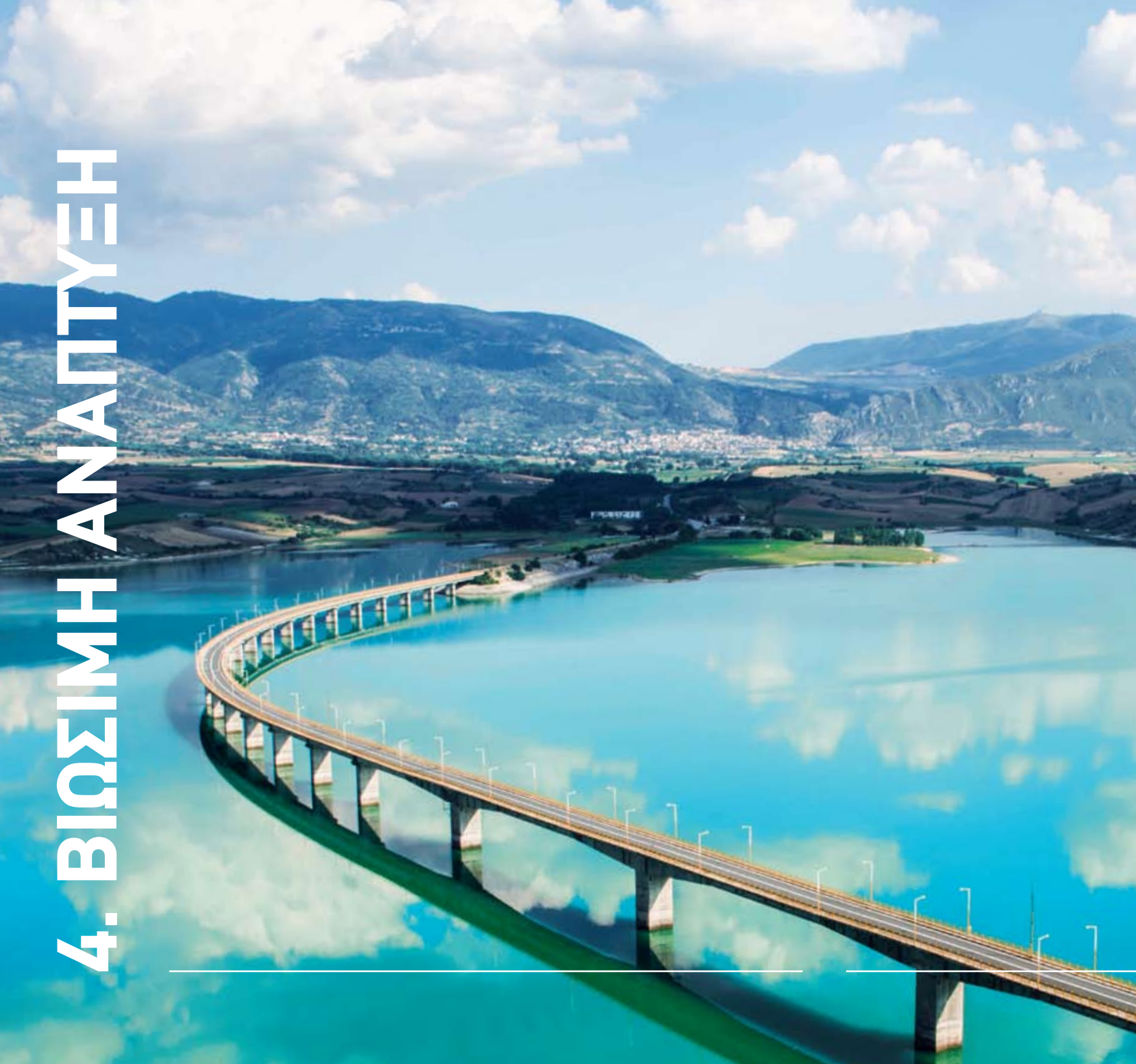
Υψηλή γέφυρα Σερβίων - Τεχνητή λίμνη Πολυφύτου
