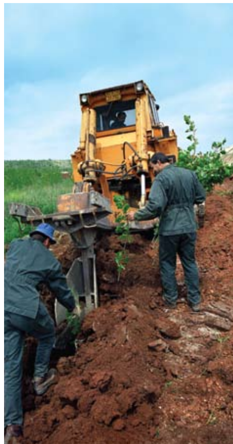
Αποκατάσταση περιβάλλοντος, δεντροφύτευση, Λιγνιτικό Κέντρο Δυτικής Μακεδονίας
