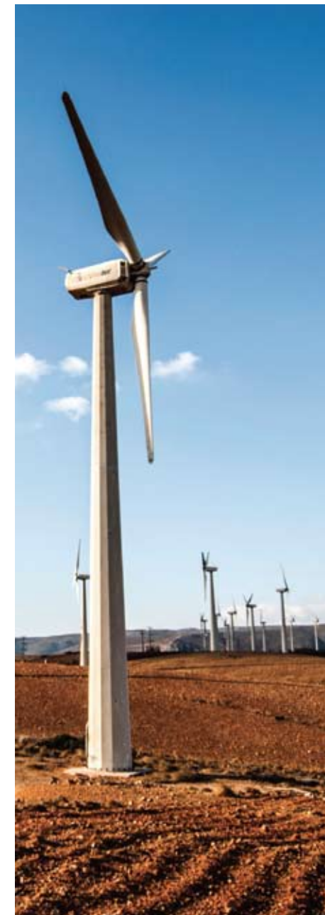
Αιολικό πάρκο Μονής Τηπού Λασιθίου
