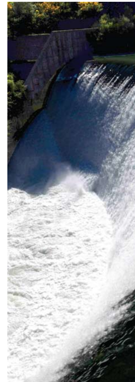
Φράγμα ΥΗΣ Λούρου
